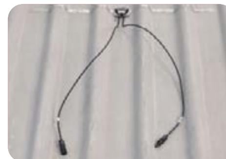
A conexão entre as telhas fotovoltaicas deve ser feita através dos conectores MC4, formando a quantidade de série e paralelo de telhas de modo que atinja os parâmetros elétricos mínimos e máximos da entrada do inversor fotovoltaico.
